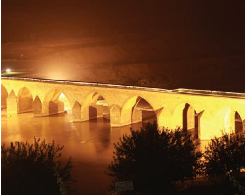
Dicle Köprüsü, Diyarbakir.
